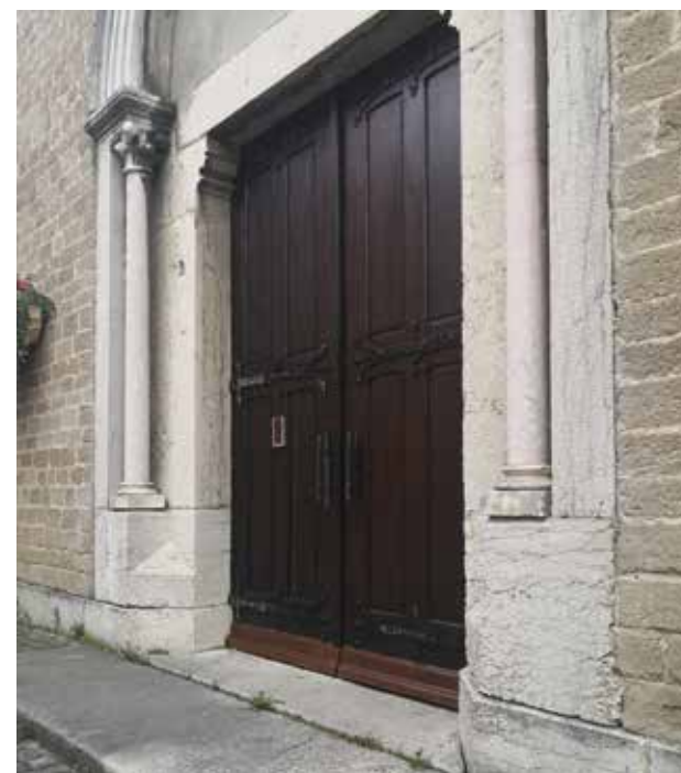
► Restauration de la porte de l'église
