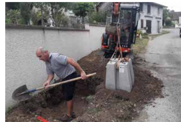
► Installation d'un lampadaire route Romaine
