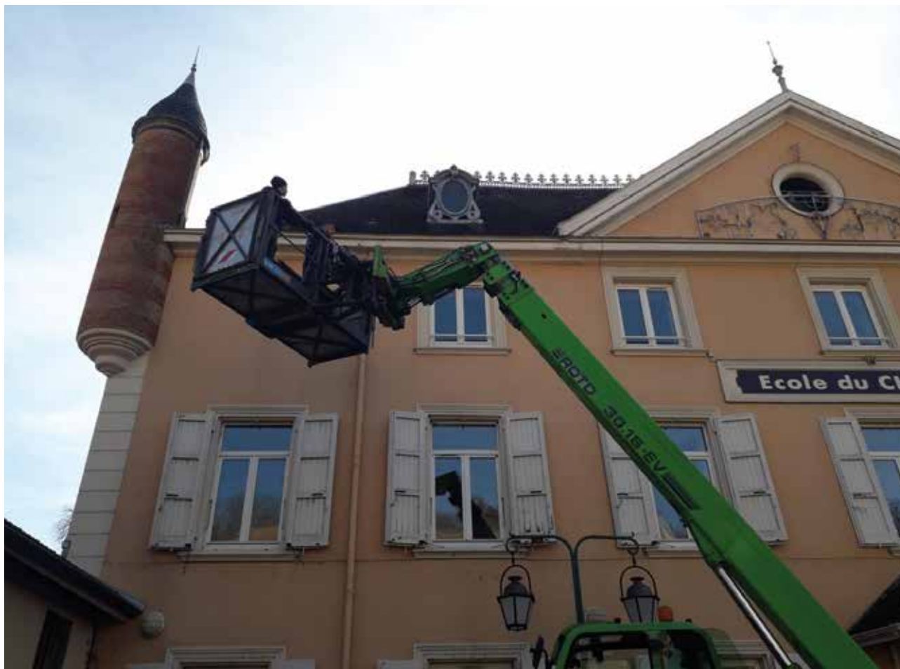
► Réparation d'une fuite sur le toit de l'école du Château
