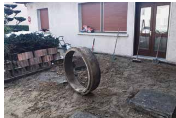
► Modification de l'accès au foyer des anciens
