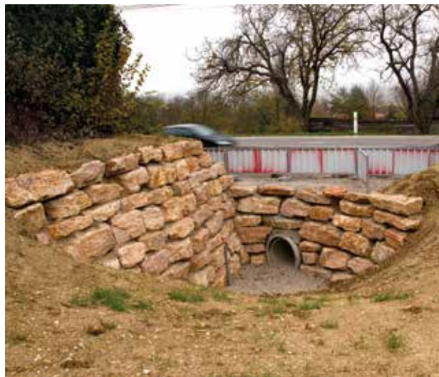
► Tunnel pour le passage de la faune
