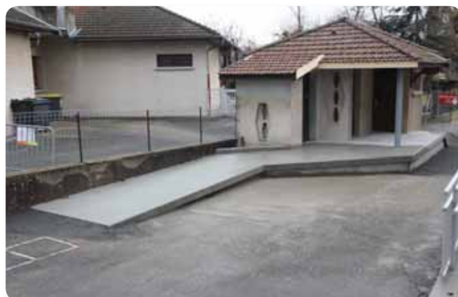
Rampe WC Centre de loisirs
