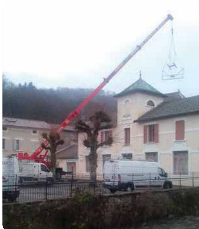
Les toilettes à l'école du Château
