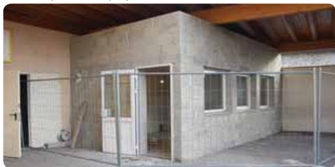
Les toilettes à l'école du Château
