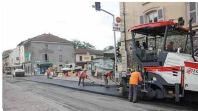
Réfection de l'enrobé de la RD 1006
