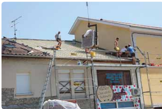
Toit Bâtiment Rue des Terreaux
