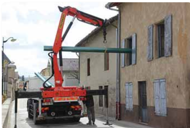
Renforcement du plancher salle d'archives
