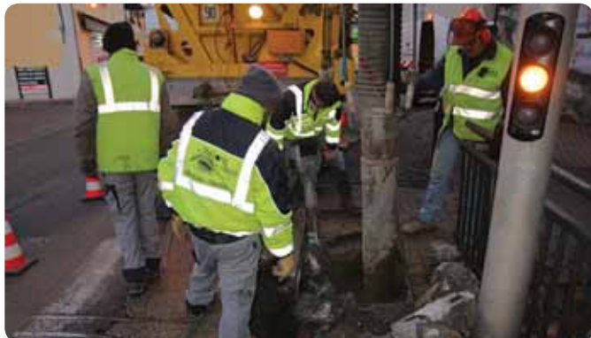
Réparation d'une fuite
