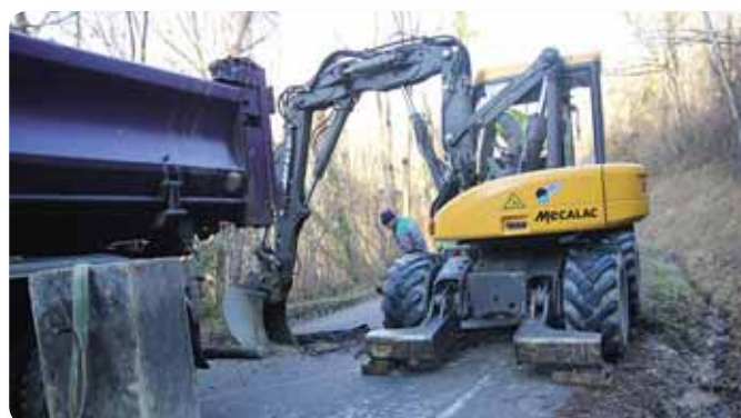
Remplacement d'un tuyau Route du Bois.
