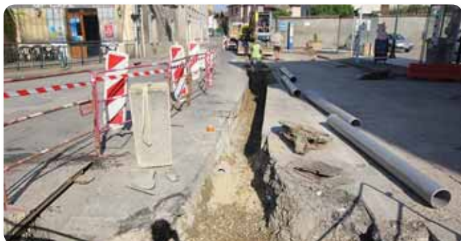
Réfections des canalisations d'eaux pluviales sous RD 1006
