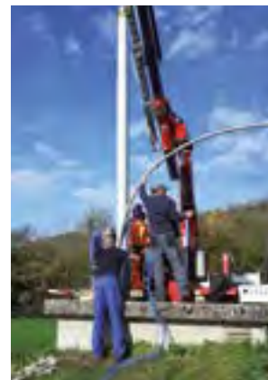
► Changement d'une pompe à la station de Vachère
