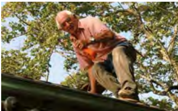
► Gilbert en charpentier sur le toit
