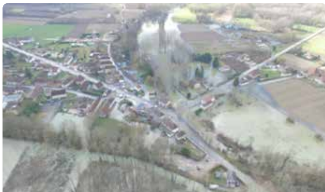
Aoste : secteur St Didier – crue du 23 janvier 2018
