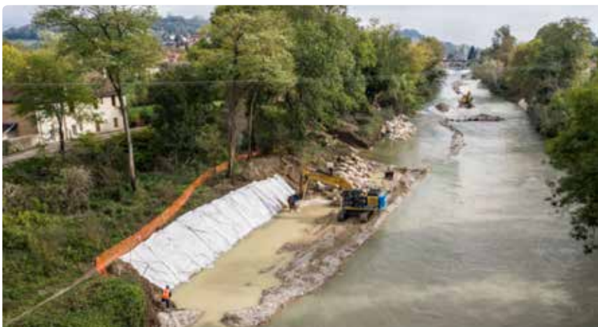
Travaux de restauration morpho-écologique du Guiers (secteur Aoste) – octobre 2019
