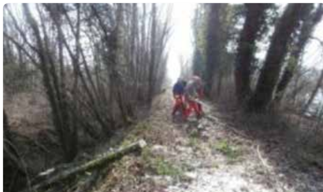
Travaux de gestion de la ripisylve
